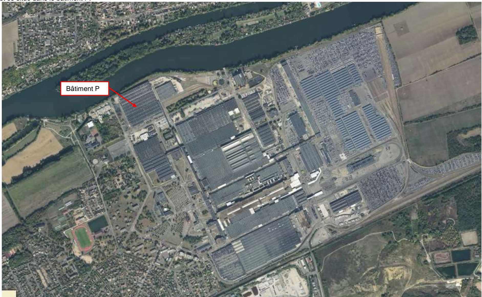
Photo 2 : Renault Flins – Localisation du bâtiment P
